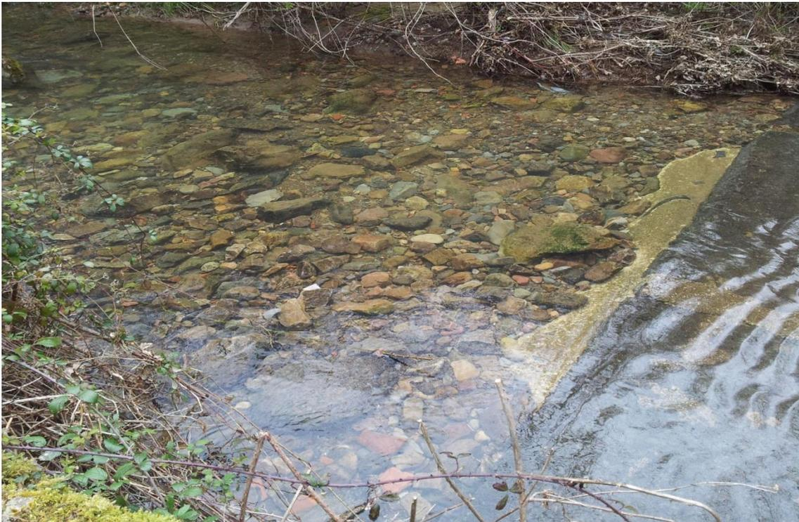
Fotografía nº 20. Detalle de aterramiento del azud
